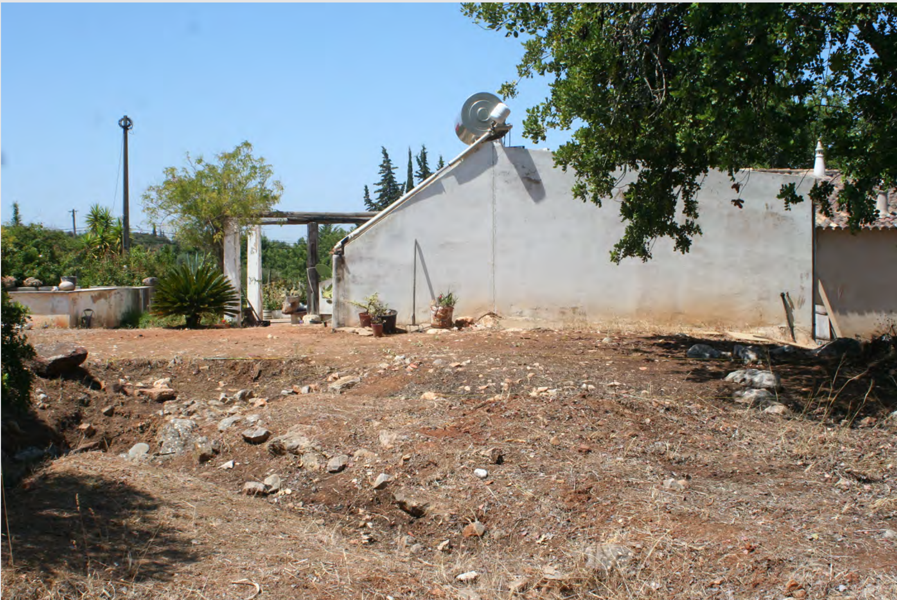
Vista da área antes do início da intervenção de 2019-20. Note-se a zona da câmara intervenionada em 1993.
