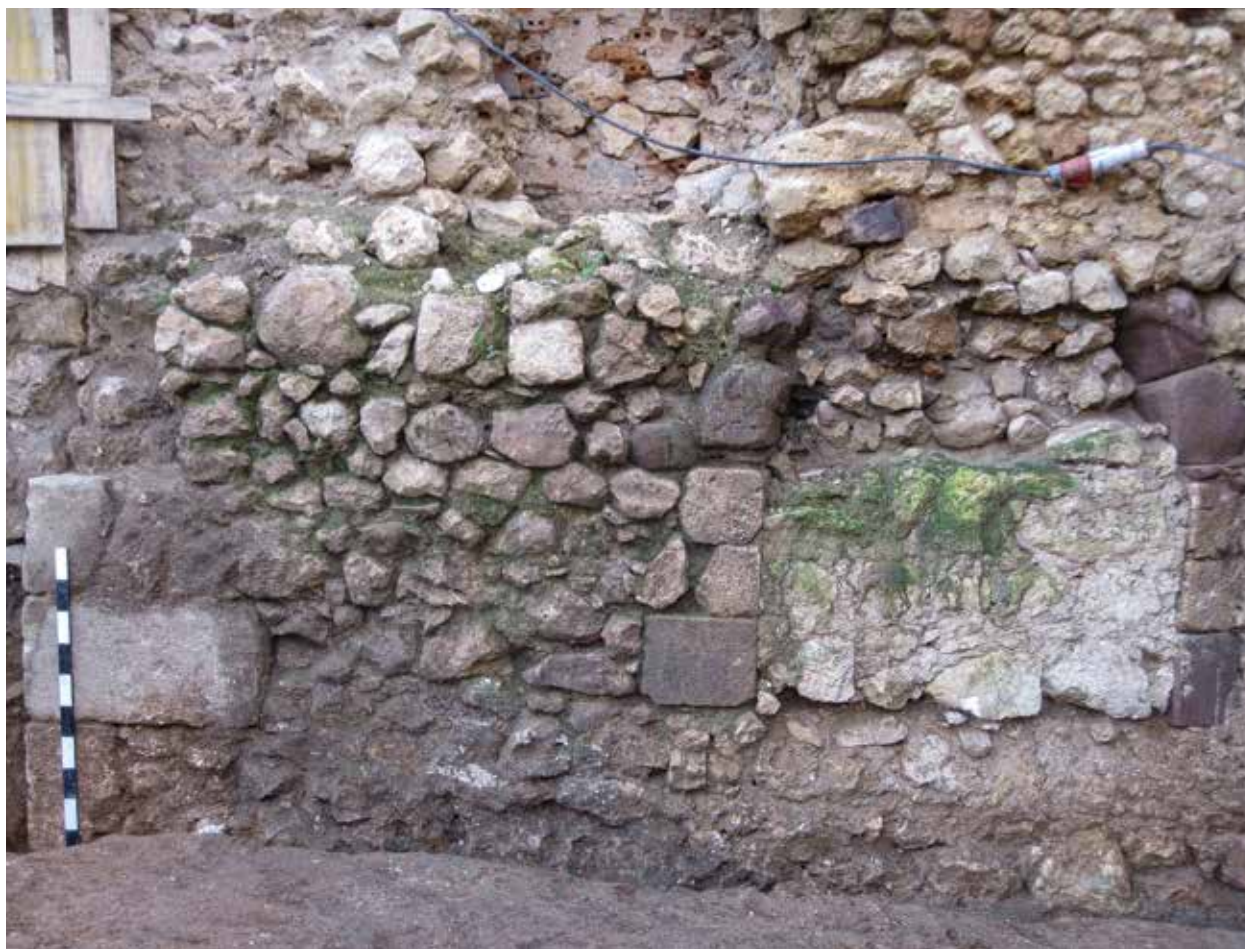
Figura 15. Abertura entaipada na Muralha, situada junto do cunhal da muralha no edifício da Rua Ernesto Cabrita, 19 – 33 (Osório et al. 2018).
